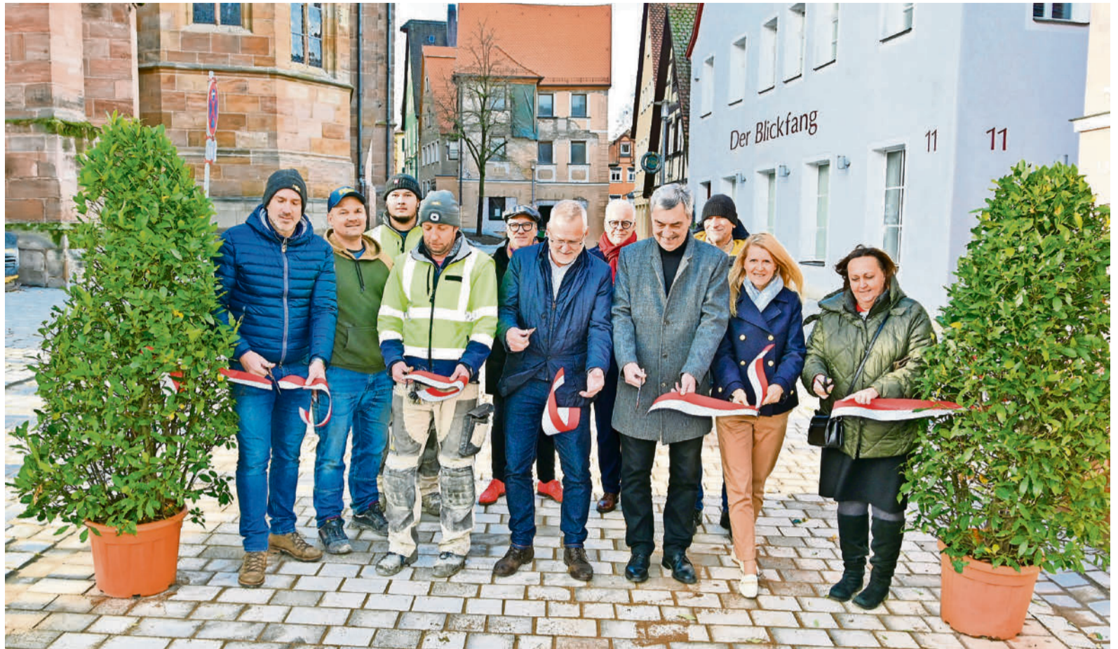
Nach siebenmonatigem Ausbau ist die Rosenberger Straße in Schwabach nun wieder frei und bietet eine bessere Aufenthaltsqualität.
