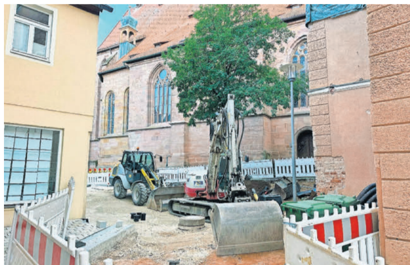
In der Rosenbergerstraße wurde seit April gebaut.
